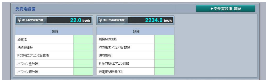
一括監視画面の受変電設備エリア
