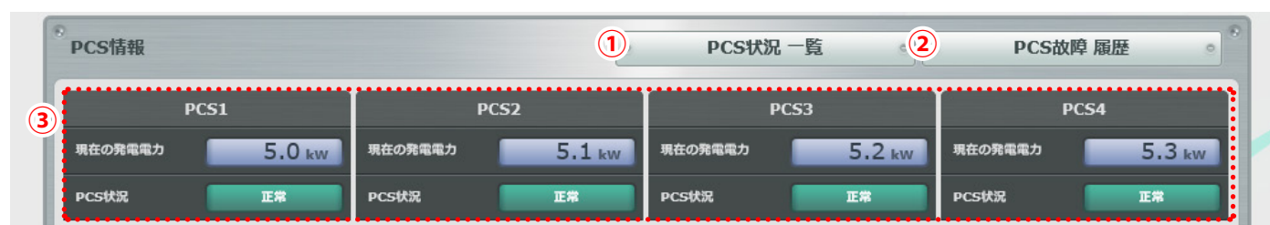
パワーコンディショナ 4 台を計測する画面例
